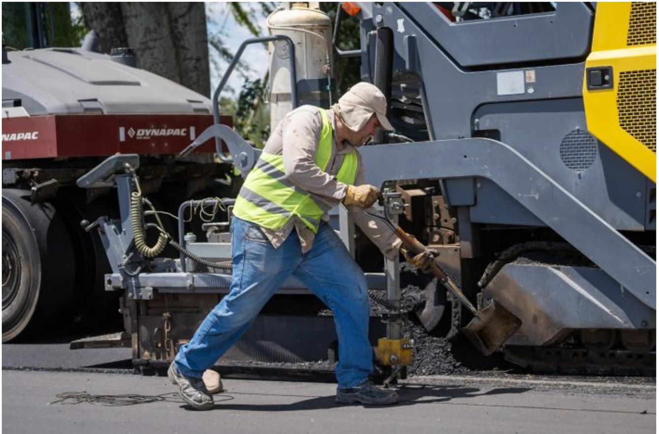
El jefe de Zona Centro de la DPV, Gastón Barcenilla, detalló que “la obra comenzó con fresado de la vieja carpeta, luego el sellado de juntas el cual previene que las fisuras que están abajo no repercutan en la superficie de la nueva carpeta y ahora ya estamos colocando el nuevo encarpelado con lo que quedará la RP 96 totalmente nueva en toda su extensión”.
