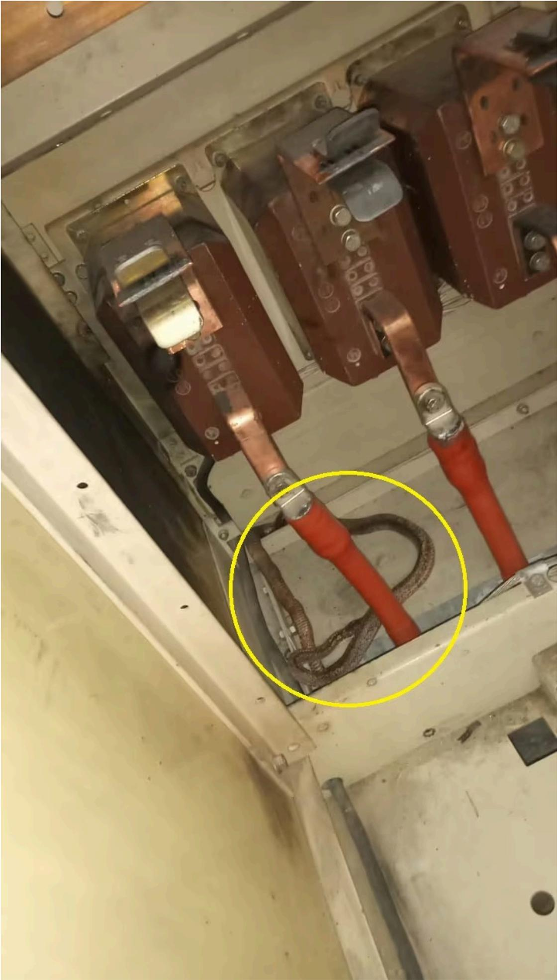
Al entrar en contacto el reptil con uno de los transformadores, se produjo un fuerte cortocircuito, que derivó en el corte de suministro eléctrico luego de que se activaran los sistemas de protección. A raíz de ello se activó, además, el despeje automático de demanda en algunas zonas de ese departamento.
