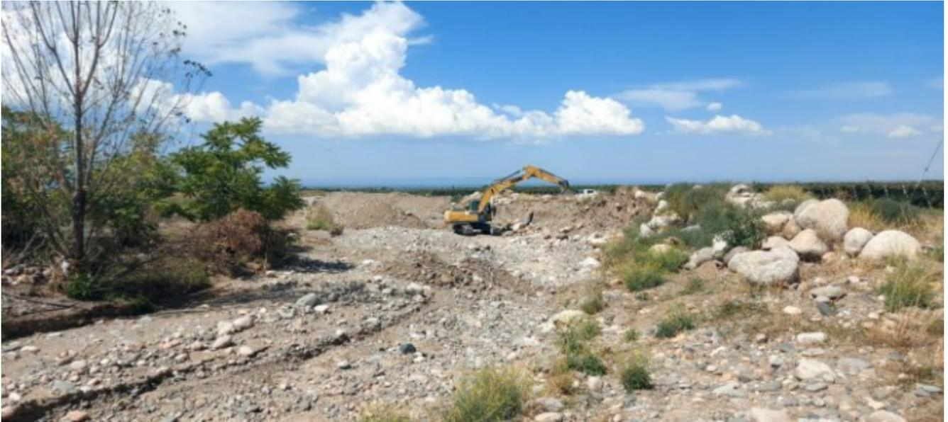
“Estamos trabajando de manera urgente en la reparación del daño causado por la crecida. Las tareas incluyen el perfilado y restitución del cauce, la protección de la margen derecha mediante enrocado y el desembanque del material arrastrado por la corriente. Todo esto, con el fin de evitar mayores daños en las propiedades cercanas”, agregó Rodríguez.
