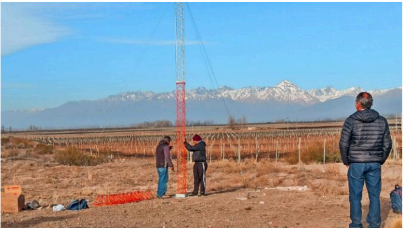
**Sobre la torre metálica se encuentran sensores de viento, temperatura, humedad, radiación y pluviómetro que proporcionan información meteorológica de la zona.**
