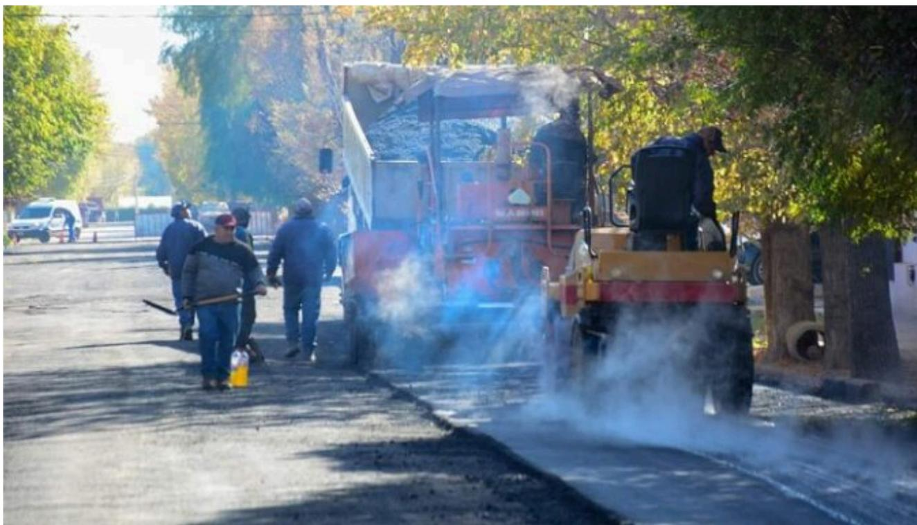
**Se debe a tareas de recambio de cañerías de cloacas y la reparación de la carpeta asfáltica.**
